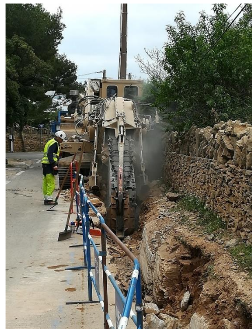
Figure 1 : activité de creusement de tranchées – Carsat Sud-Est
